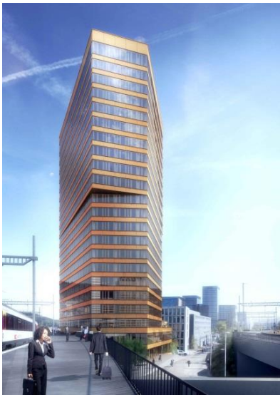
Geschäftshaus mit idealer Verkehrsanbindung: der 80 Meter hohe Andresturm beim Bahnhof Zürich Oerlikon. Bild: SBB Immobilien.
