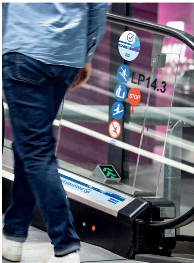
Die Reduzierung von Bakterien und Viren in einer Rolltreppe, die mit KONE Handrail-Sanitizer (2 UV-C-Geräte pro Handlauf) ausgestattet ist, wurde gegen *Escherichia coli*-Bakterien und den MS2 Bakteriophagen-Virus getestet. MS2 wird in der Regel als Surrogat für humane virale Erreger wie Norovirus und Coronavirus in Desinfektionswirksamkeitstests verwendet.
