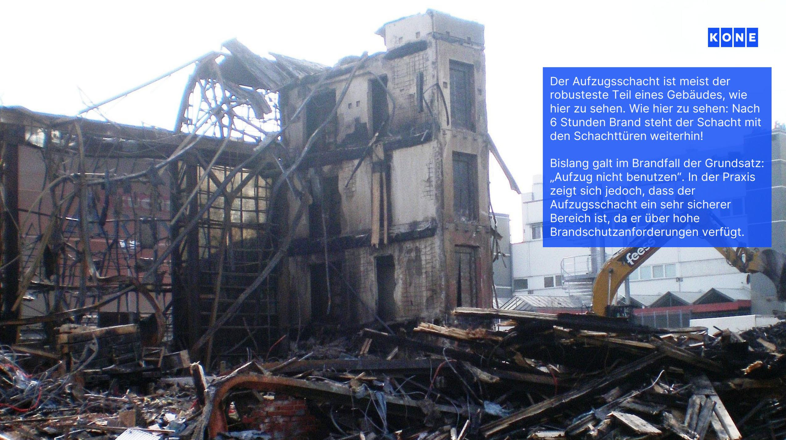
Der Aufzugsschacht ist meist der robusteste Teil eines Gebäudes, wie hier zu sehen. Wie hier zu sehen: Nach 6 Stunden Brand steht der Schacht mit den Schachttüren weiterhin!
