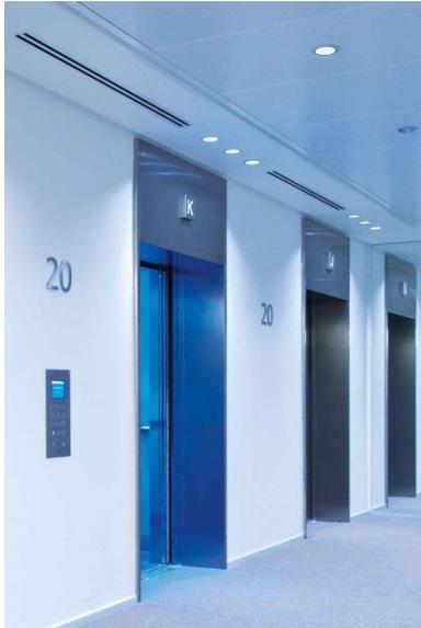
Comme dans le building parisien Tour First, les six ascenseurs MonoSpace 700 installés dans l'Andreasturm sont dirigés par le contrôle de destination Kone Destination. Cela permet de réduire considérablement les arrêts et d'améliorer ainsi l'efficacité de ce système d'ascenseur.
