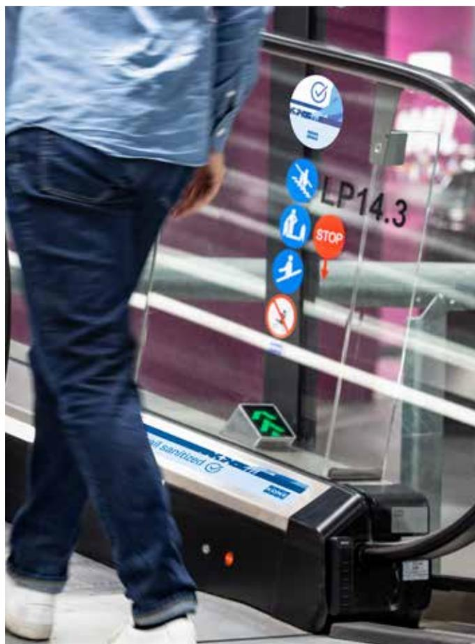
La réduction des bactéries et des virus dans un escalier mécanique équipé du KONE Handrail-Sanitizer (2 appareils UV-C par main courante) a été testée du point de vue de la bactérie *Escherichia coli* et du virus bactériophage MS2. Le MS2 est généralement utilisé comme indicateur pour les agents pathogènes viraux humains tels que les norovirus et les coronavirus dans les tests d'efficacité de désinfection.
